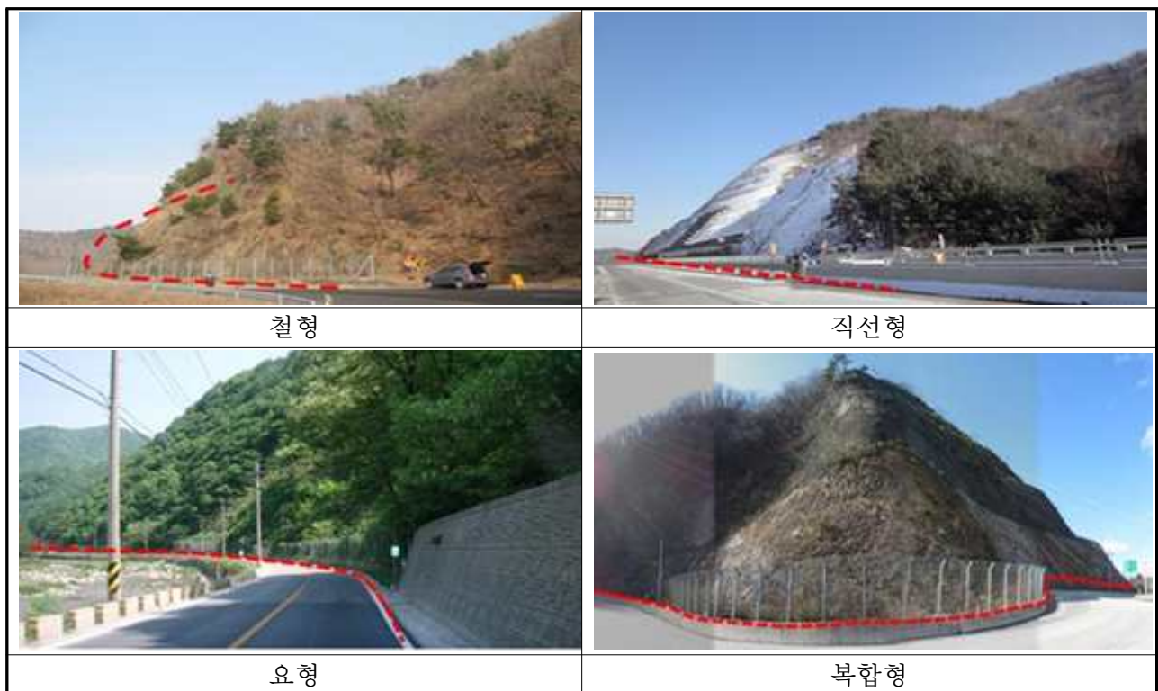
<그림 17> 급경사지 종단형상에 대한 현장 예시
