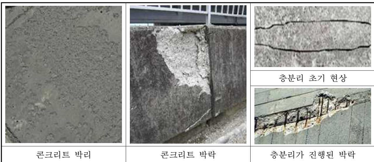
<그림 29> 콘크리트 구조물의 박리/박락 현상 예시
