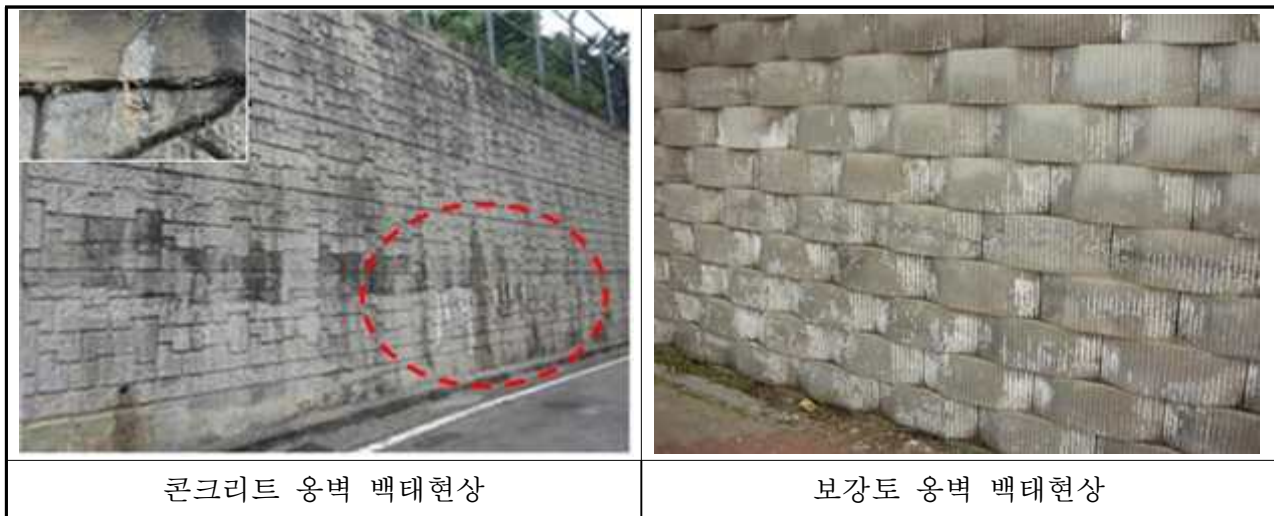
<그림 32> 옹벽 백태 발생 현상 예시
