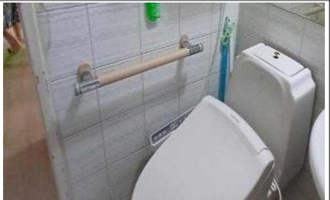
양변기 안전 손잡이 설치
