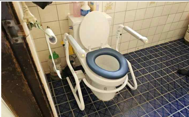
양변기 안전 손잡이 설치
